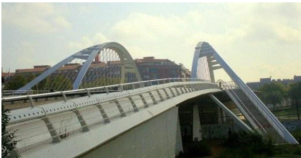
Puente Bach de Roda-Felip II, en Barcelona, con el tramo central sostenido por dos arcos inclinados con tirantes
