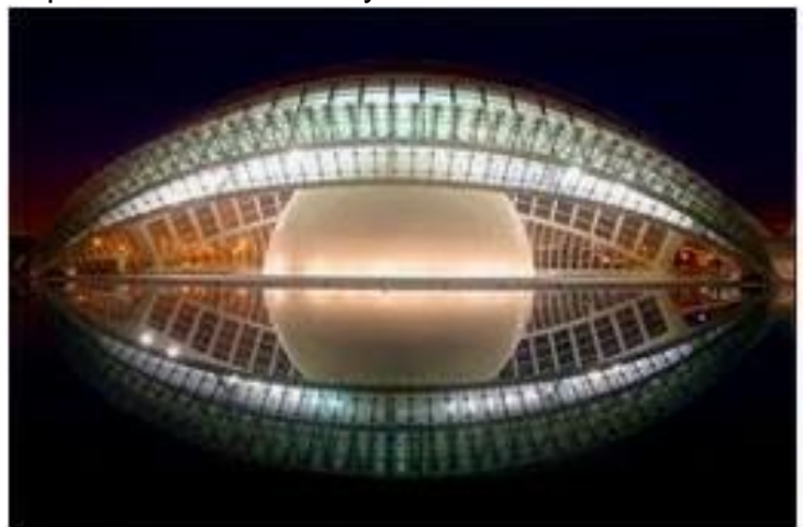
Sala de proyecciones y planetario L'Hemisfèric de la Ciudad de las Artes y las Ciencias de Valencia, con forma de medio ojo que se completa con su reflejo en el agua
